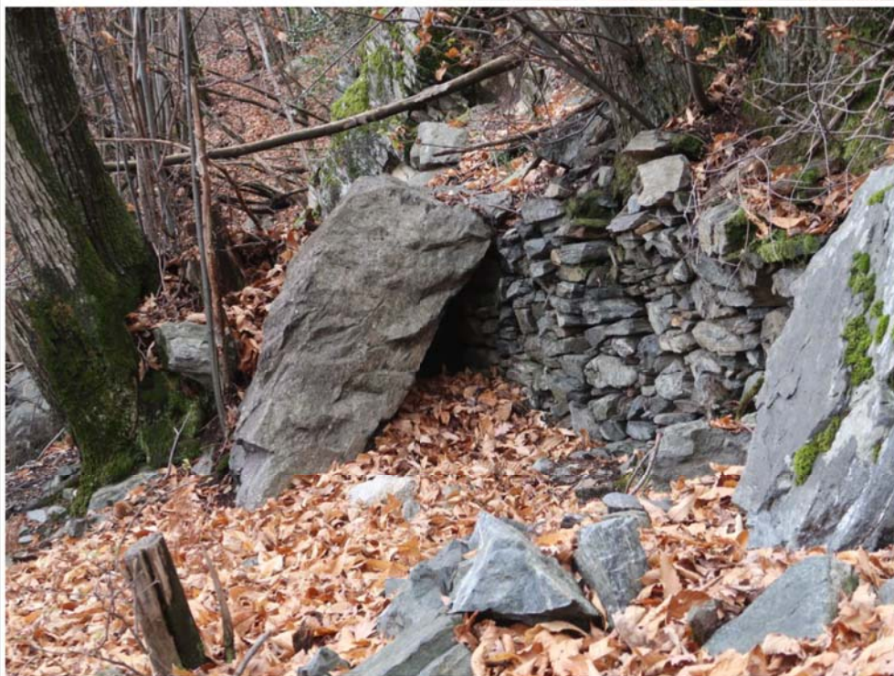
Foto 12 Deposito di un blocco su di un muro a secco a monte dell'area edificata.
