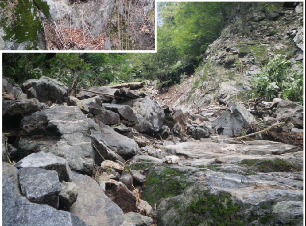
Foto 02 Alveo del riale Nosetto, sotto alla zona di stacco, zona di transito e deposito; materiale rimobilizzabile in caso di piena.
