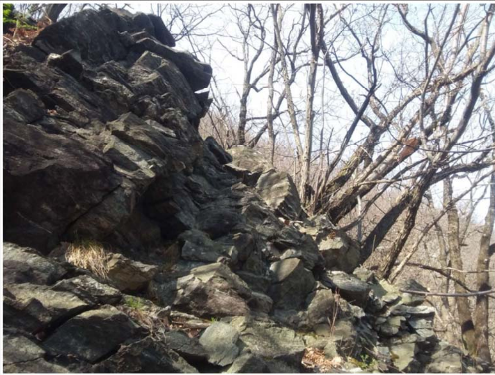
Foto 04 Crinale a destra del riale Nosetto, zona di stacco, anche tracce recenti, di blocchi e massi.
