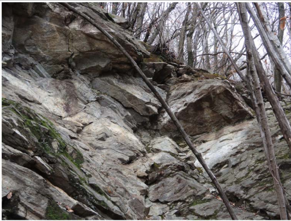
Foto 13 Affioramento nella zona centrale con segni di stacchi recenti di blocchi.
