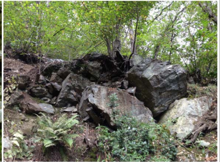
Foto 2: blocchi instabili nell'area di distacco del franamento (ca. 490 mslm)
