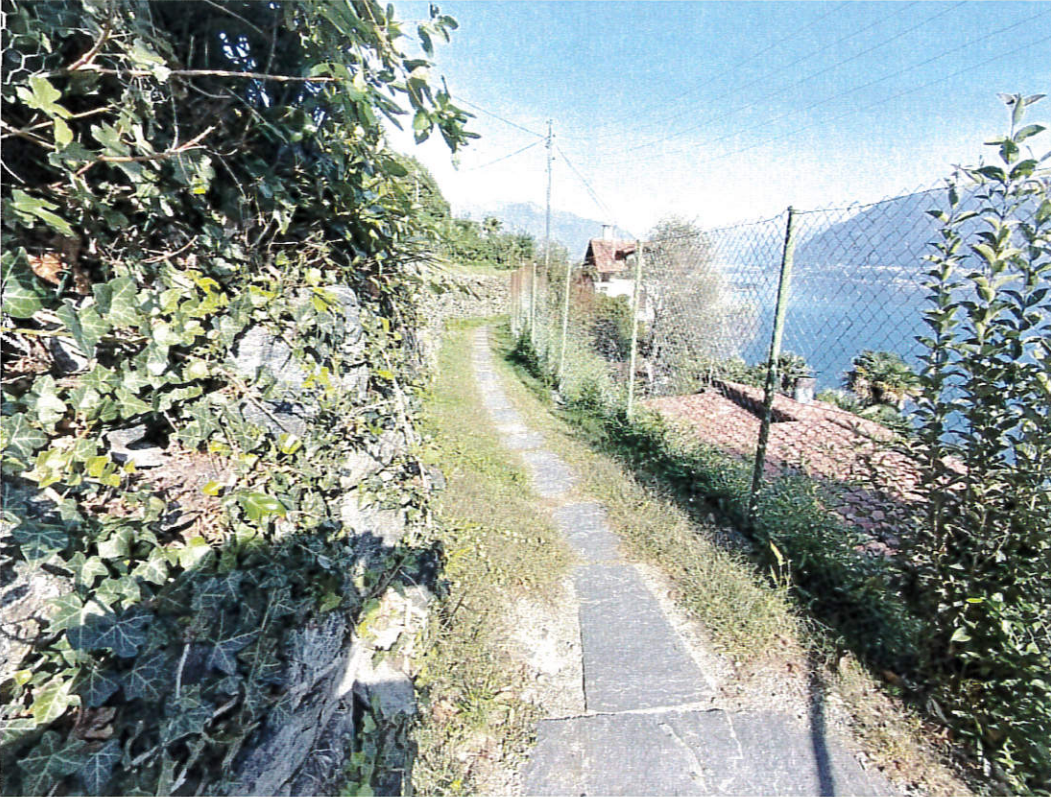
Figura 1: La posa della condotta sul sentiero Via Barcone nella zona alta
