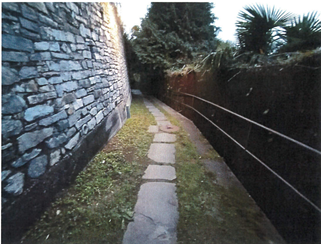
Figura 5: Situazione tipo della posa della condotta lungo i percorsi pedonali. A monte murature (necessità di prove a futura memoria) e a valle murature (necessità di prove a futura memoria), presenza di roccia e altre infrastrutture. In funzione delle murature presenti, anche lo scavo dovrà essere mantenuto ad una quota minima, sarà quindi necessario utilizzare spesso tubazioni isolate
