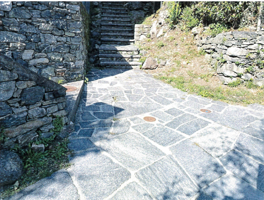
Figura 2: Le saracinesche attuali nel comparto Via Barcone, dove c'è il semi-travaccone da risanare
