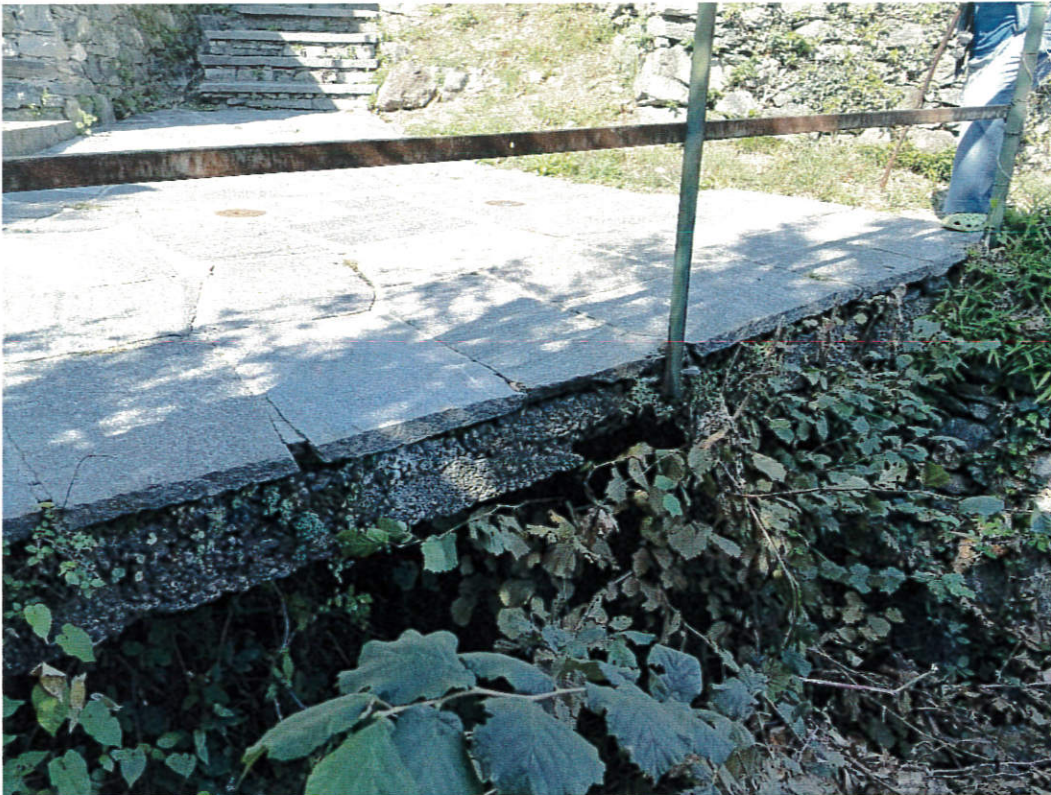
Figura 3: Dettaglio del travaccone attuale, in cui è posata la vecchia condotta. Sarà necessario, in occasione dei lavori, rifare il passaggio per l'acqua, mettendola a norma per evitare problemi futuri
