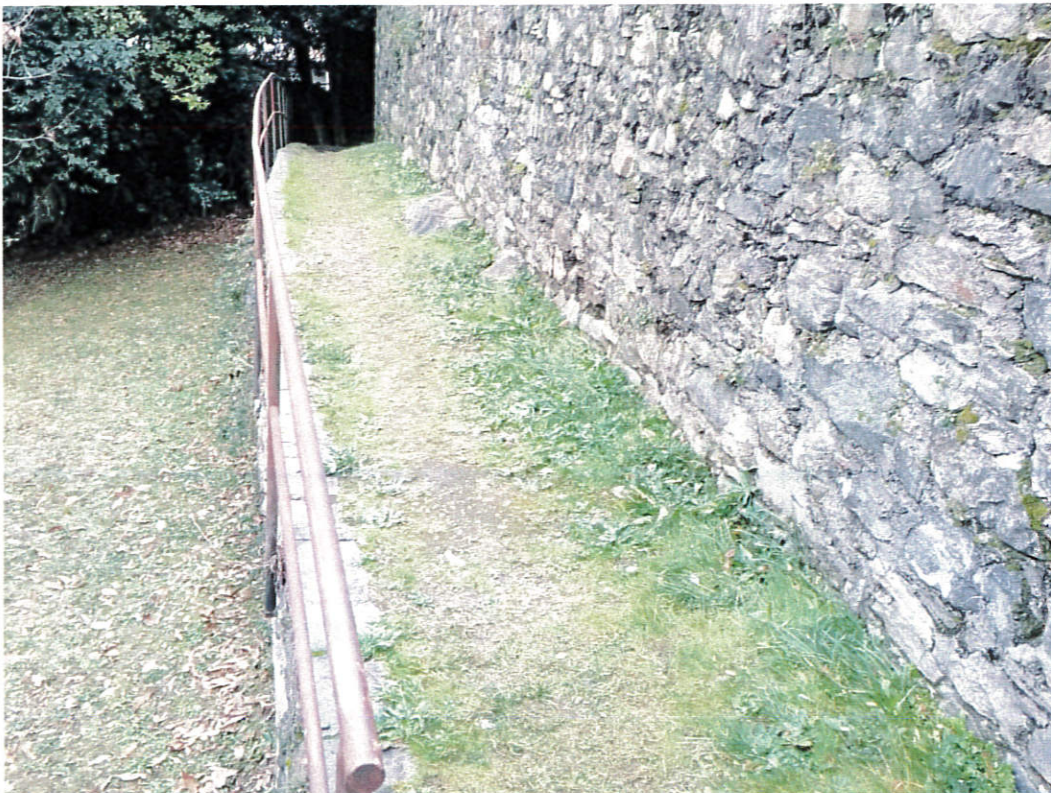
Figura 4: Situazione tipo della posa della condotta lungo i percorsi pedonali. A monte murature (necessità di prove a futura memoria) e a valle murature (necessità di prove a futura memoria), presenza di roccia e altre infrastrutture
