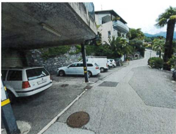
Fotografie 3+4: A sinistra la pavimentazione ammalorata e a destra il pilastro da risanare.
