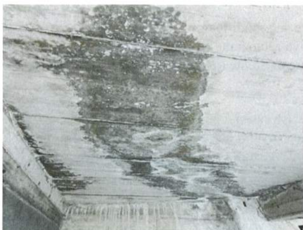
Fotografie 1+2: A sinistra la soletta di copertura con infiltrazioni di acqua e la presenza di efflorescenze. A destra alcune infiltrazioni in corrispondenza del giunto soletta – architrave.
