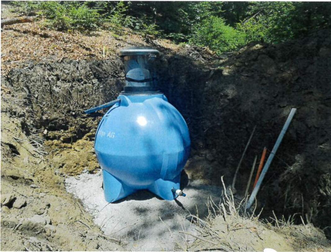
Figura 9 Serbatoio posato
